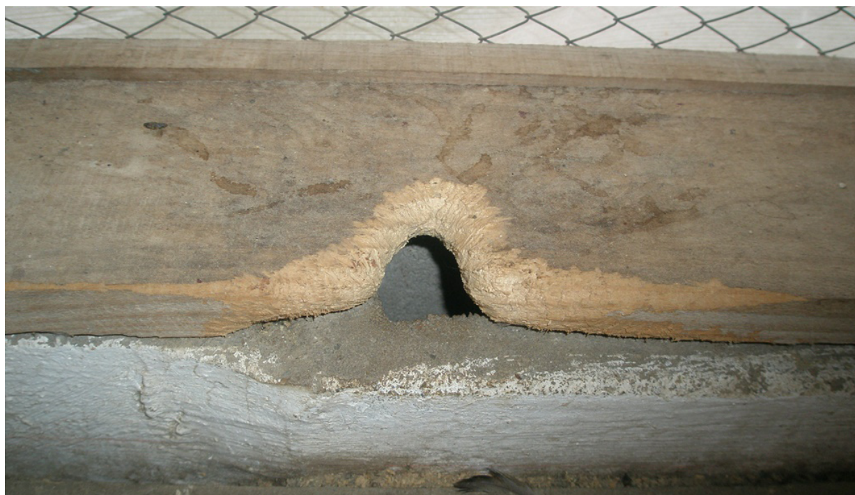
Imagen 7. Rattus rattus y Rattus norvegicus roen diferentes elementos de su entorno. Para ello, comúnmente proyectan su mandíbula inferior hacia adelante y, mientras los incisivos superiores sujetan el objeto, los inferiores actúan sobre él con movimientos rápidos y potentes. En condiciones naturales, tienen predilección por roer diferentes estructuras de madera. En estos casos, el aspecto de las roeduras proporciona información sobre el tiempo transcurrido desde que el daño fue provocado; la acción de los incisivos conservará la tonalidad blanquecina por aproximadamente una semana.
